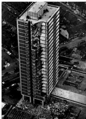
Рис. 1 – Обрушение части панельного жилого дома Ronan Point
