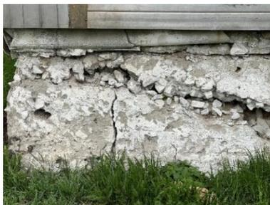
Рис.3. Пример монолитной бетонной конструкции (цоколя), с трещинами и косослоем бетона
