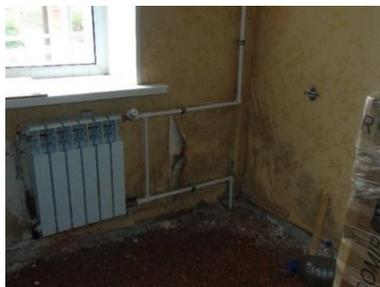
Рис.1. Пример разрушения внутренней отделки помещений
