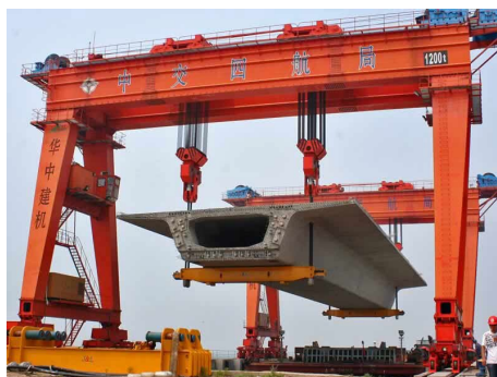
Рис. 3 Применение автоматизированного крана при строительстве моста
