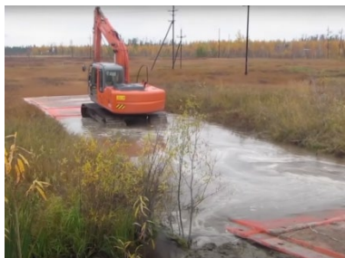
Рис. 2 Мобильное дорожное покрытие «Мобистек-80»
