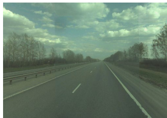
Рис. 2 Реконструируемый участок автомобильной дороги Р-22 «Каспий» км 422+000, апрель 2014 г
