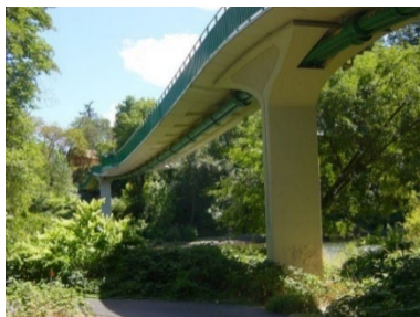
Рис. 2 Преднапряжённый железобетонный мост в ботаническом саду в городе Грантс-Пасс, Орегон, США
