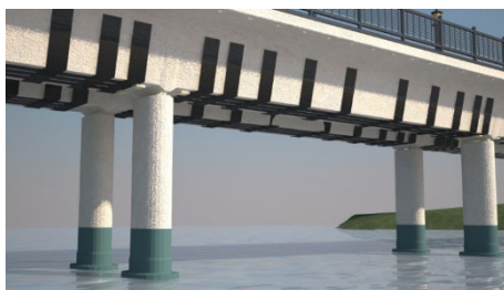
Рис. 1 Укрепление перекрытия моста с помощью углепластика
