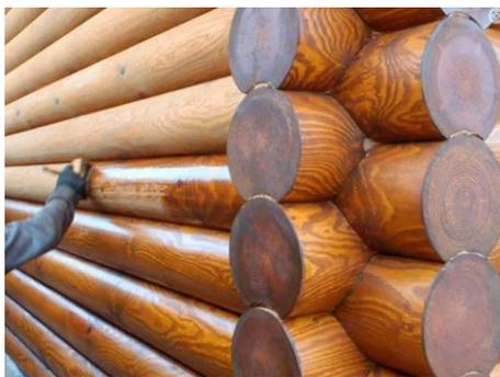
Рис. 4. Нанесение защитного раствора на внешнюю поверхность деревянного сруба.
