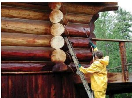
Рис. 1. Обработка деревянного сруба лакокрасочными материалами с одновременным антисептированием.
