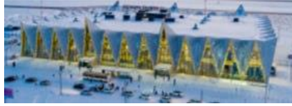
Рис. 8. Аэропорт Новый Уренгой, архитектурное бюро Битус, 2020 [5]
