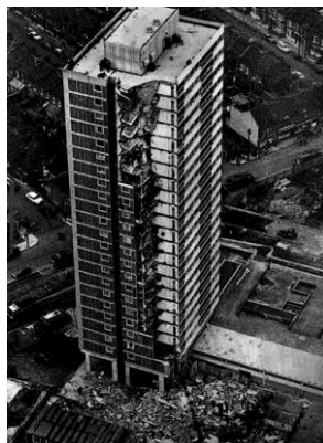
Рис. 1 – Обрушение части панельного жилого дома Ronan Point
