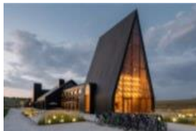
Рис. 4. Центр Гостеприимства, вид с северного фасада [7]
