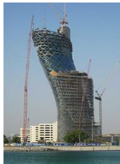
Рис. 4 Строительство башни «Capital Gate»
