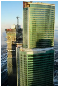
Рис. 7 Башня «Евразия» г.Москва
