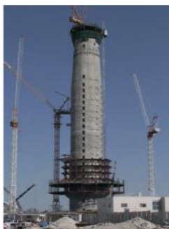
Рис. 3 Строительство башни «AspireTower»
