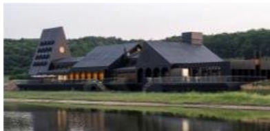
Рис.3. Центр Гостеприимства, вид с восточного фасада [7]
