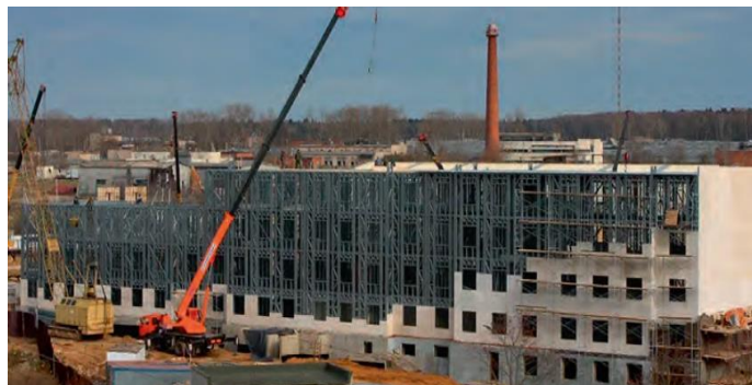
Рис. 1 Монтаж металлических конструкций жилого дома
