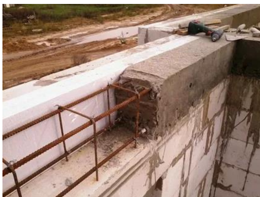
Рис. 1 Устройство сейсмопояса
