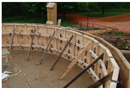
Рис. 1 Сборная деревянная опалубка
