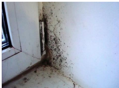
Рис. 2 Грибок и плесень на откосах
