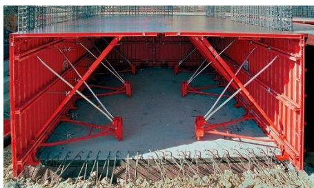
Рис 3. Объемно переставная опалубка
