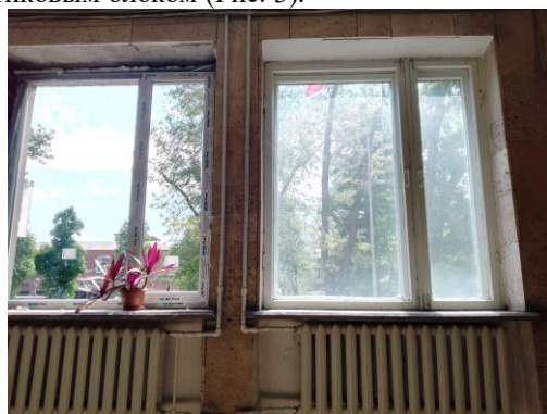
Рис. 3 Сравнимые оконные блоки (слева – металлопластиковый (М/П); справа – деревянный (Д))
