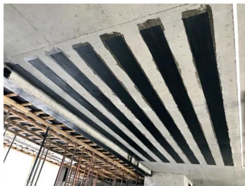
Рис. 1 Усиление плиты перекрытия углеволокном
