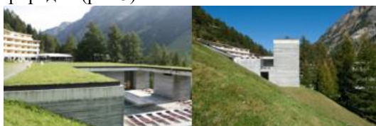
Рис.3 Термы в Вальсе. Архитектор Петер Цумтора
