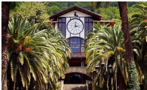
Рис. 3 - Деревянное здание «Гагрипш» в Гаграх
