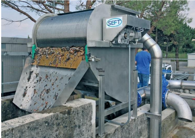
Рис. 2 Сита для удаления крупных отходов.
