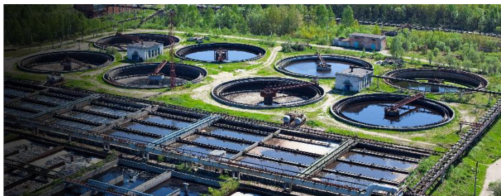
Рис. 1 Сооружения для очистки.
