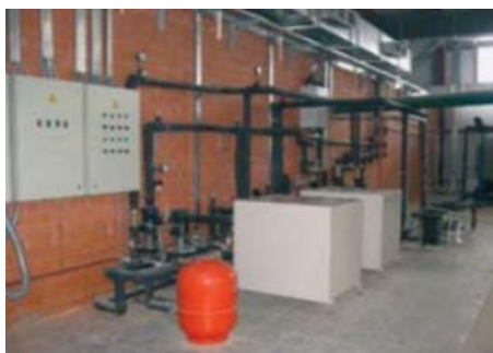
Рис. 3. Теплонасосная система теплоснабжения здания очистных сооружений.
