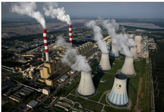
Рис. 1 Внешний вид предприятия тепловой энергетики
