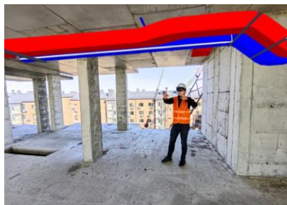
Рис. 1 Применение технологий смешанной реальности на строительном объекте
