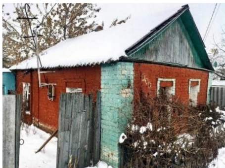
Рис. 1. Общий вид здания
