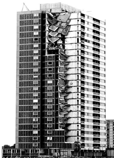
Рис. 1 Обрушение части панельного жилого дома Ronan Point
