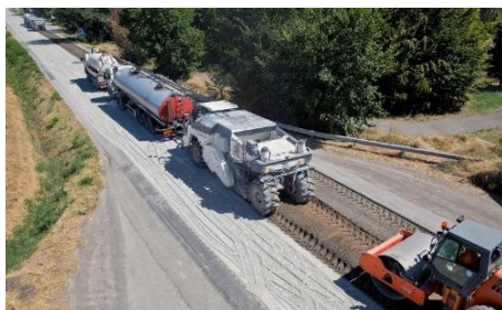
Рис.1 Технология укрепления грунта цементом
