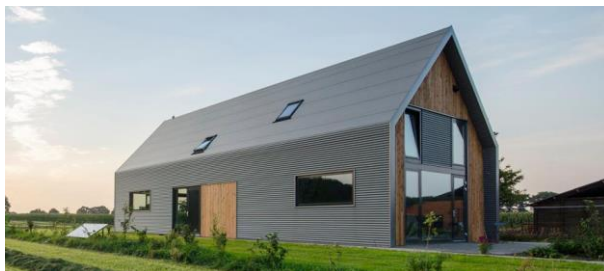
Рис.2 Коттедж с нулевым энергопотреблением в г. Хенгело
