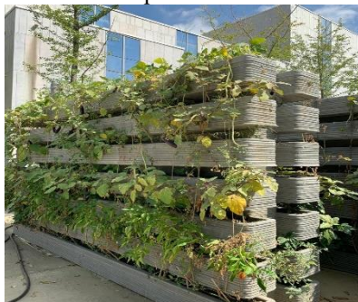
Рис. 1. Бетонная ландшафтная стена, напечатанная на 3D – принтере фирмой WINSUN (Китай)
