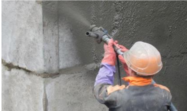
Рис. 1 Процесс нанесения защиты влагоизоляционных средств
