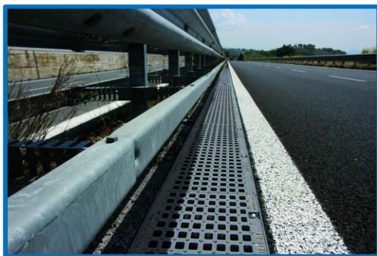
Рис. 2 Пример продольного дренажа
