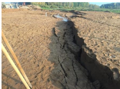
Рис. 3 Результат уплотнения основания земляного полотна
