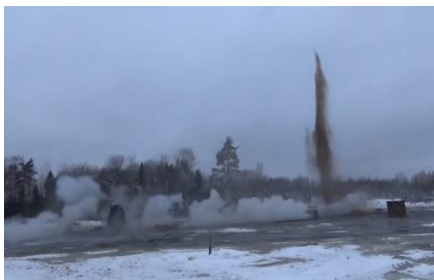
Рис. 2 Момент взрыва зарядов в скважинах
