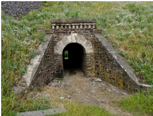
Рис. 1 Каменная арочная водопропускная труба
