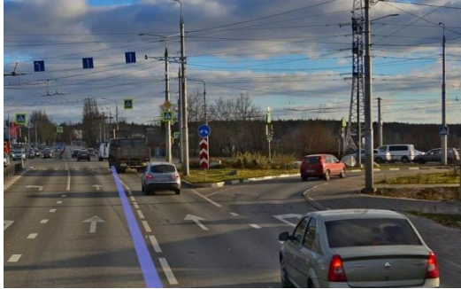
Рис. 3 Разделение движения в пространстве: канализирование движения
