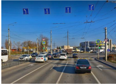
Рис. 4 Формирование однородного транспортного потока: специализация полос на проезжей части
