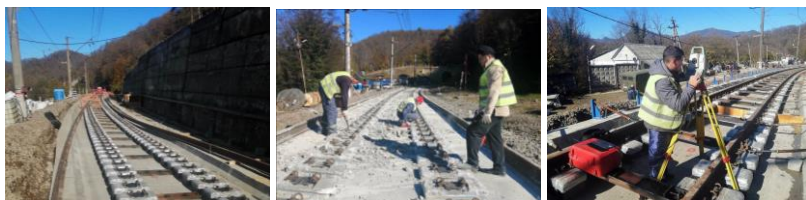
Рис. 2 Проведение капитального ремонта пути в Среднем и Малом петлевых тоннелях
