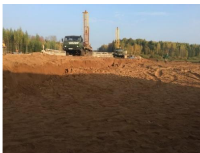
Рис. 1 Бурение скважин перед установкой зарядов
