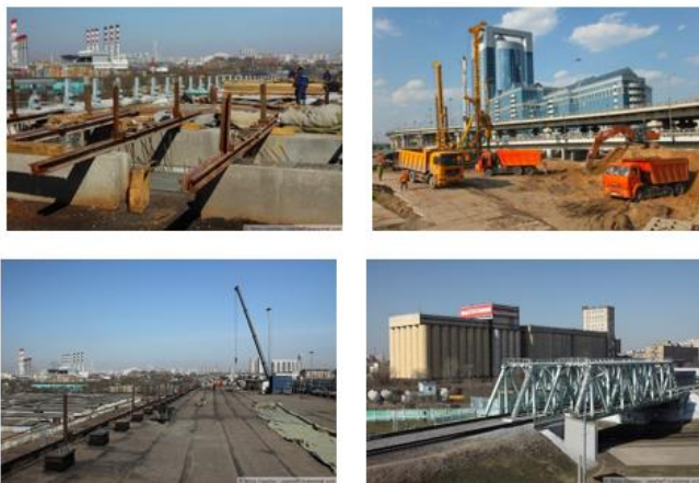
Рис. 1 Строительство эстакады ТТК у Москва-Сити
