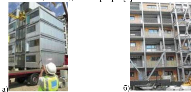
Рис. 4 а) монтаж модулей; б) монтаж переходной галереи
