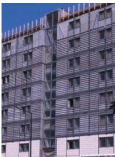
Рис. 2 Смонтированные модули перед установкой фасада
