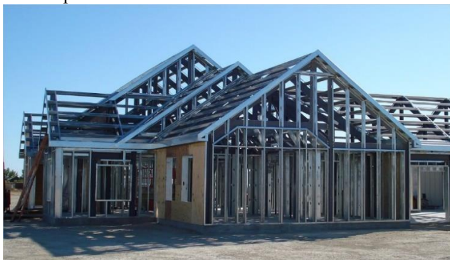
Рис. 2 Переработанный металл в строительстве здания
