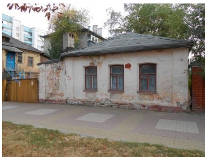
Рис. 1 Общий вид здания
