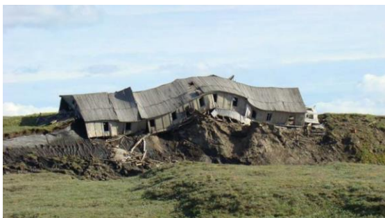
Рис. 4 Деформация здания заброшенной воинской части в низовье Енисея за счет неравномерного вытаявания подземного льда
