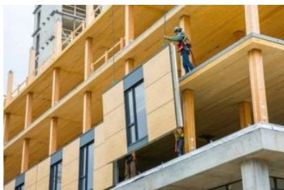
Рис. 1 Монтаж стеновой CLT панели
