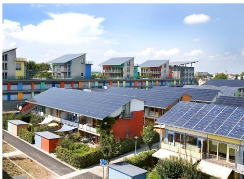
Рис. 3 Солнечные батареи на крышах таунхаусов, Германия
