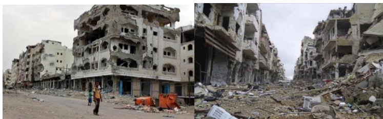
Рис. 2 Разрушенные здания города Йемена
