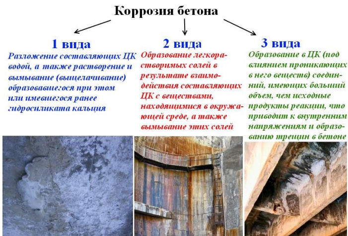
Рис. 1 Виды коррозии бетона в жидкой среде
