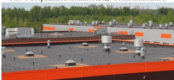
Рис. 2 Молниеприемная сетка- Тросовый вариант.
