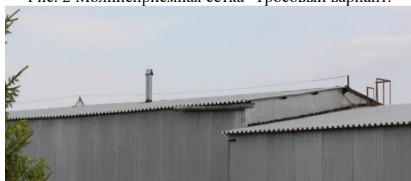
Рис. 3 Тросовый молниеотвод
