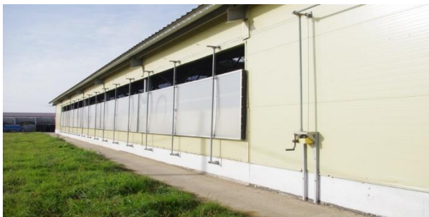
Рис. 4 Система вентиляционных штор
