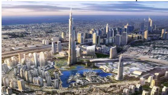
Рис. 1 Панорама на здание Бурдж-Халифа
