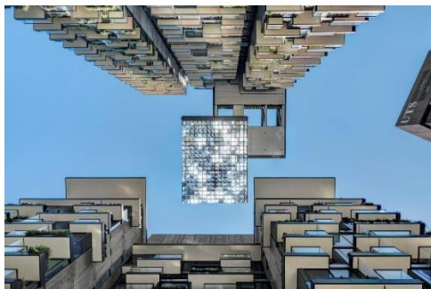
Рис. 5 Моторизованный гелиостат, закрепленный на консоли, улавливает солнечный свет и отражает его в область парка, затененную башней
