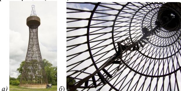
Рис. 2 Фото водонапорной башни В.Г. Шухова в Полибине в настоящее время: а – вид снаружи; б – вид внутри основного гиперболоида
