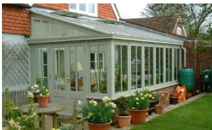
Рис. 3 Стеклянное сооружение с опорой на одну стену дома. Зимний сад
