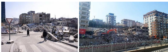
Рис. 1 Разрушенные города Турции после землетрясений в 2023 году
