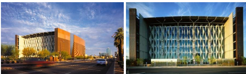
Рис. 1 Центральная библиотека имени Бертона Барра, Финикс, штат Аризона, США, архитекторы: DWL Architects, Will Bruder., 1995.
