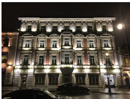
Рис. 2 Акцентная подсветка здания.
