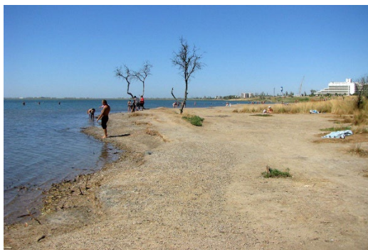
Рис. 1 Состояние набережной г. Саки на момент 2015 г.
