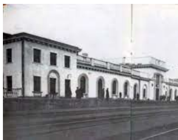
Рис. 6 Здание железнодорожного вокзала в Белгороде, построенное в 1949 г. Архивное фото 1950 г.
