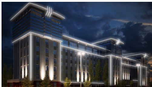
Рис. 3 Контурная подсветка здания.
