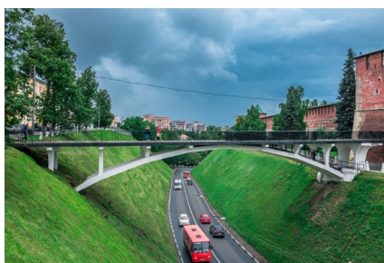
Рис. 5 Пешеходный мост над Зеленским съездом в городе Нижний Новгород [6]
