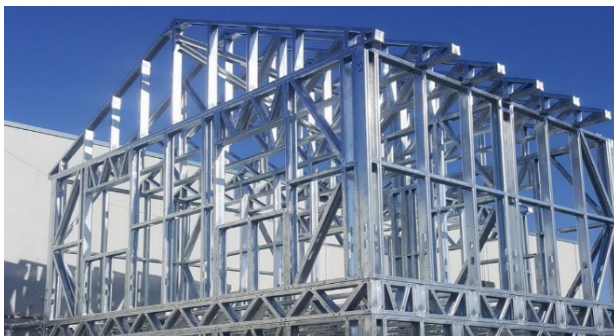
Рис. 1 3D-печать металлоконструкций компании LifeTec Construction Group
