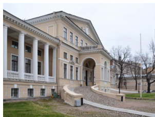
Рис. 2 Отмывка проекта здания, фото здания после реставрации.
