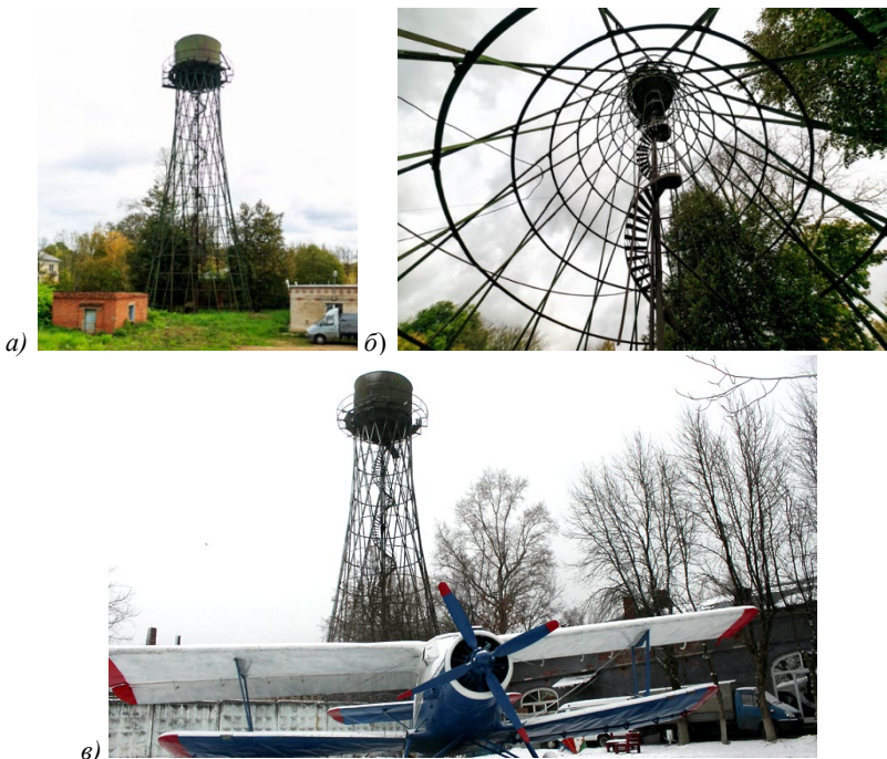
Рис. 2 Фото водонапорной башни В.Г. Шухова в пос. Луговая в настоящее время: а — общий вид; б — вид внутри гиперboloида; в — вид на фоне самолета АН-2
