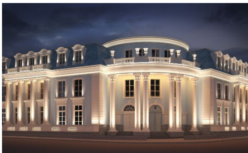
Рис. 1 Заливающая подсветка здания.
