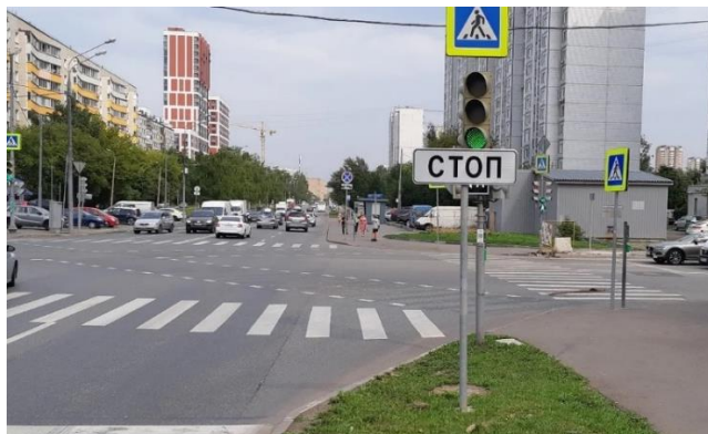
Рис. 2 Пример нарушения. Знак 1.12, дублирующий разметку стоп-линии, закрывает видимость нижних секций светофора
