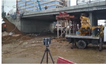
Рис. 1 3-D сканер Faro Focus 3DX130 в процессе съёмки геометрии путепровода
