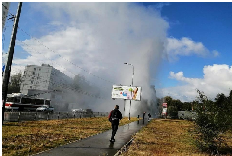
Рис. 3 Пример прорыва трубопровода
