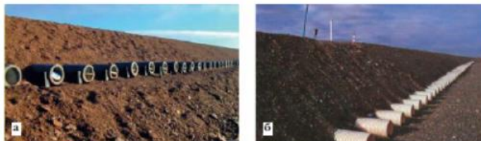
Рис. 2 Поперечные охлаждающие трубы: а) железобетонные б) пластмассовые
