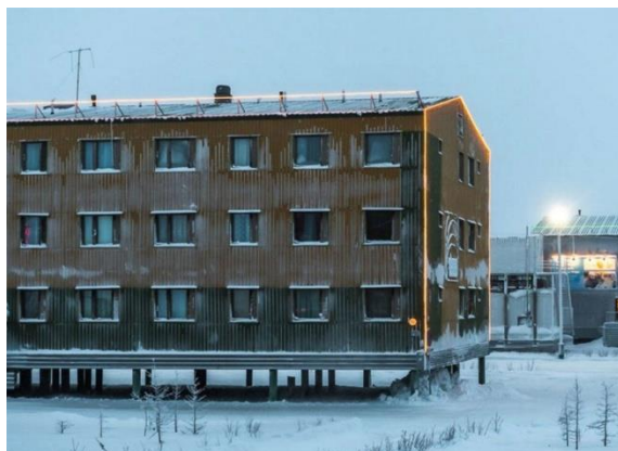
Рис. 2 Проветриваемое подполье в жилом доме
