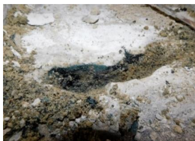
Рис. 1 Разрез плиточного клея под кислотоупорную плитку
