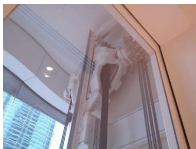
Рис. 6 Фотография лифтовой лебёдки лифта с КВШ без противовеса
