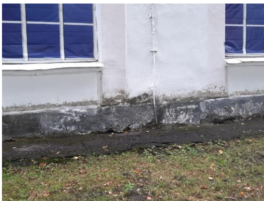
Рис. 1 Биокоррозия фундамента
