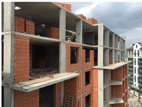
Рис. 3 Жилой дом с монолитным каркасом и стеновым заполнением из керамического кирпича
