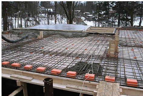
Рис. 3 Армирование монолитного железобетонного перекрытия
