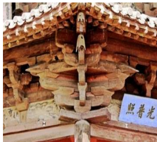
Рис. 2 Доугун – система подкровельных кронштейнов
