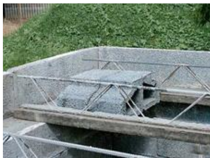
Рис. 4 Сборно-монолитное перекрытие
