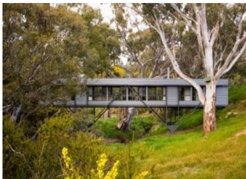
Рис. 1 Дом-мост. Макс Приткард
