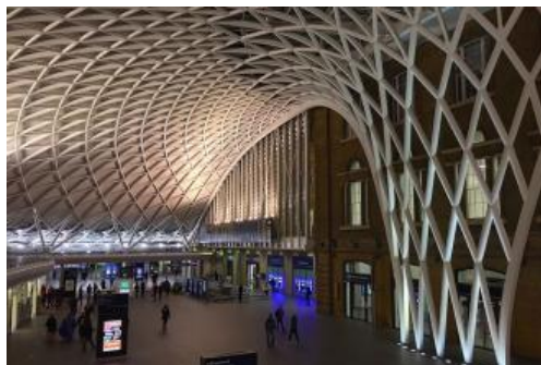
Рис. 5 Оболочка, как покрытие части здания. станция Кингс Кросс в Лондоне, Англия, 2013 г [5]
