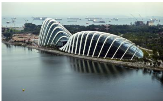
Рис. 7 Оболочка, как здание. Сингапур [6]
