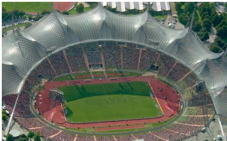
Рис. 5 Покрытие олимпийского стадиона в Мюнхене
