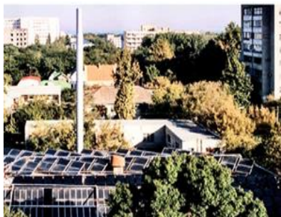
Рис. 1 Гелиоустановка котельной в г. Анапа
