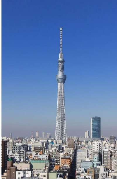
Figure. Tokyo Skytree Tower (東京スカイツリー)
