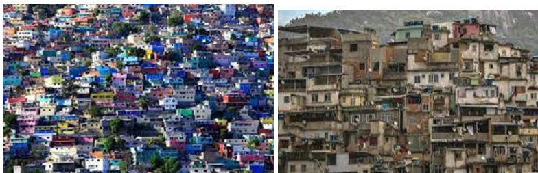
Рис. 3 Бетонные конструкции в Порт-о-Пренсе в 2022 году
