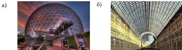
Рис. 1 а- Построенный для Всемирной выставки 1967 года, Биосфир Монреаль; б- Остекленное цилиндрическое покрытие Верхних торговых рядов (ГУМа)
