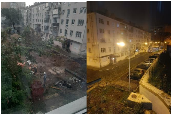
Рис. 3 Двор по ул. Попова, 30 до и после реконструкции. (Фото автора)
