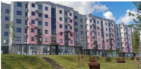
Рис. 2 Оформление входов на уровне земли ЖК «Новая жизнь» по Белгородской области
