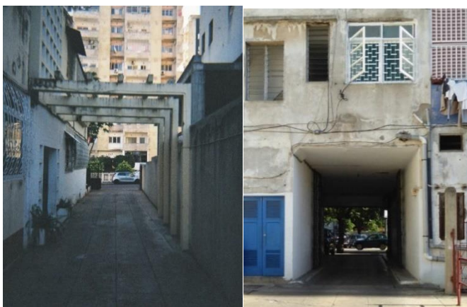
Рис. 2 Доступ во внутренние помещения каждого здания
