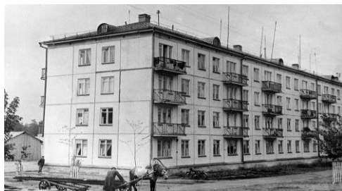
Рис. 1 Первый панельный дом
