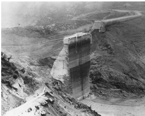
Рис. 2 «Обрушение дамбы»
