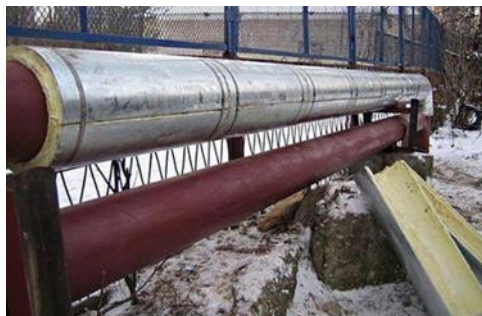
Рис. 2 Теплоизоляция минеральной ватой
