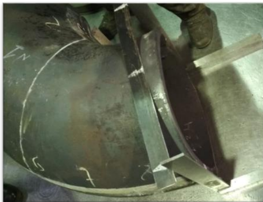
Рис. 1 Разметка под расточку торцов отвода сегодня.
