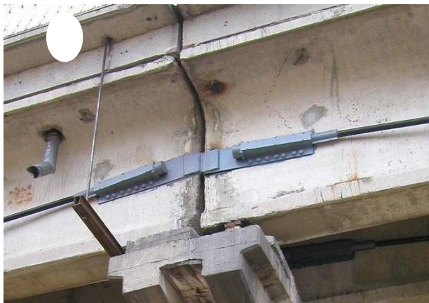
Рис. 2 Усиления железобетонных балок предварительно напряженными тжжами
