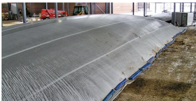
Рис. 1. Прогрев бетона методом «термоса»
