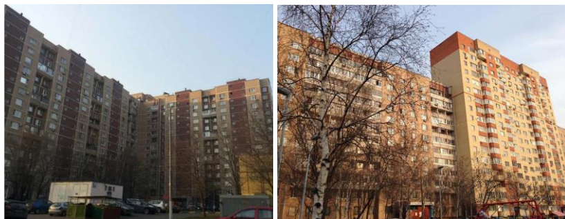
Рис. 4. Примеры крупнопанельных жилых домов четвертого периода застройки
