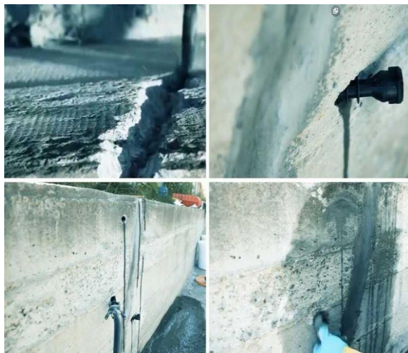
Рис. 1 Этапы выполнения работ инъектирования бетона: подготовка рабочей бетонной поверхности, установка пакеров, инъектирование бетона
