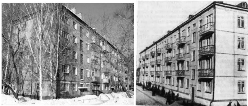
Рис. 2. Примеры крупнопанельных жилых домов второго периода застройки
