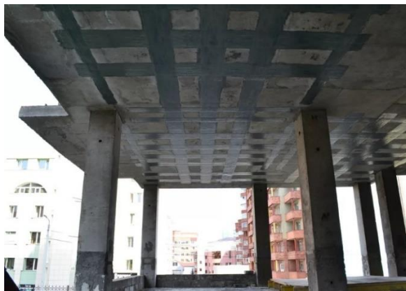
Рис. 3 Усиление конструкций здания углепластиком
