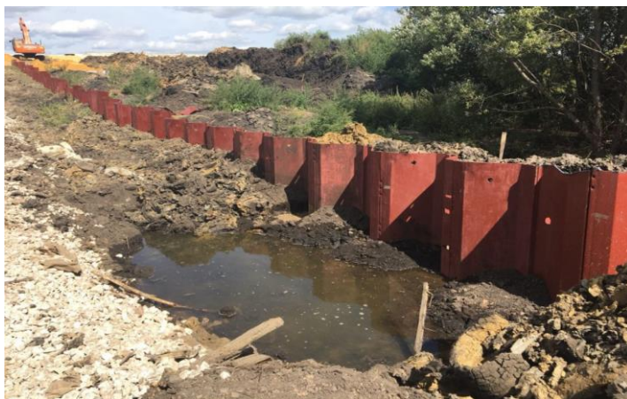
Рис. 2. Использование шпунтового металлического ограждения
