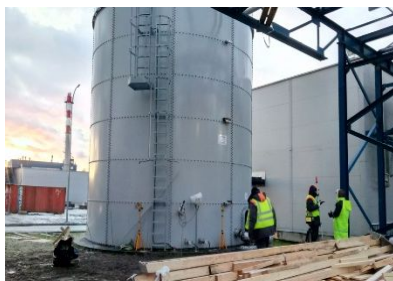
Рис. 5 Работы по выравниванию резервуара в Ленинградской области
