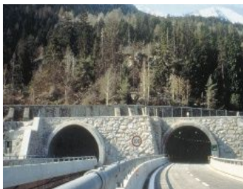
Рис. 1 Автодорожный тоннель на Юге Франции
