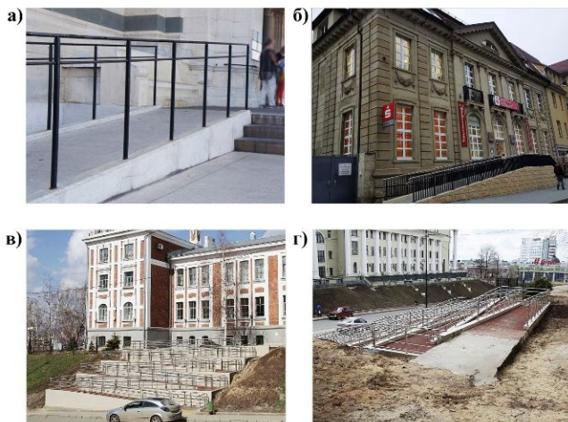
Рис. 1. Примеры адаптации исторических зданий: а – пандус собора Нотр-Дам-де-ла-Гард, Франция; б – пандус у здания банка, Германия; в, г – пандус у здания Федерации шахмат Республики Татарстан, г. Казань
