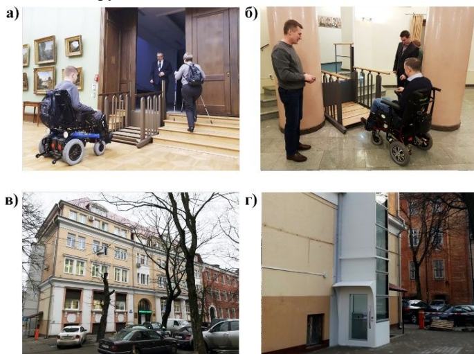
Рис. 3. Проекты компании «Observer»: а – лестница трансформер в Третьяковской галерее, г. Москва; б – лестница трансформер к Калининградском областном драматическом театре; в, г – лифт, оборудованный в здании поликлиники, г. Калининград;
