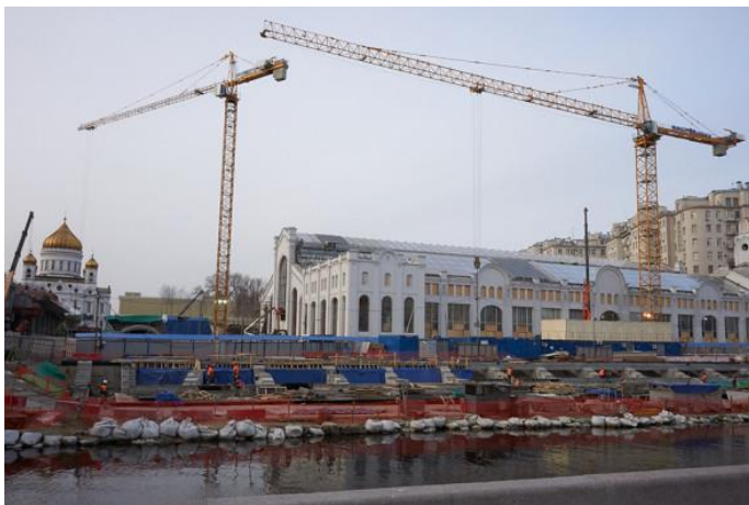
Рис.3 Рабочий процесс реконструкции Территория бывшей ГЭС-2 в г. Москва. Россия.
