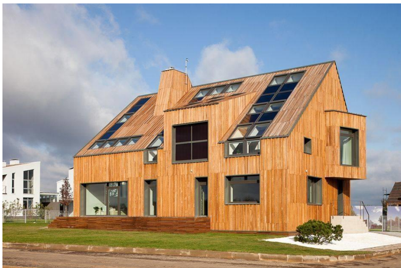
Рис. 3. «Активный дом» в Наро-Фоминском районе Подмосковья
