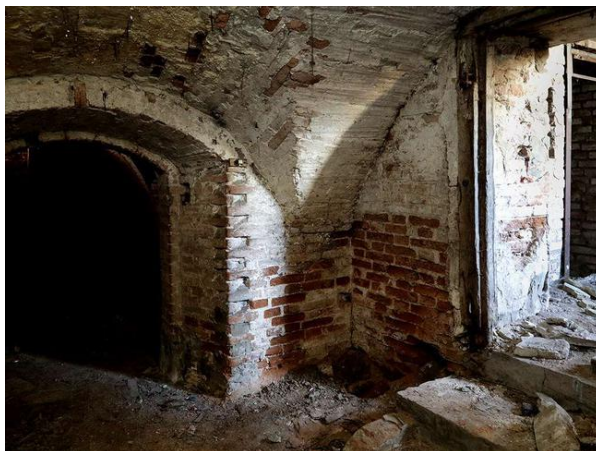
Рис. 4. Подвал жилого дома Мачурина
