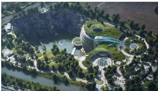
Рис. 1. Размещение отеля на дне карьерной выемки, Китай.
