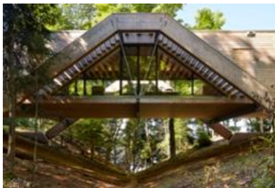
Рис.2 Bridge House в Канаде от LLAMA urban design
