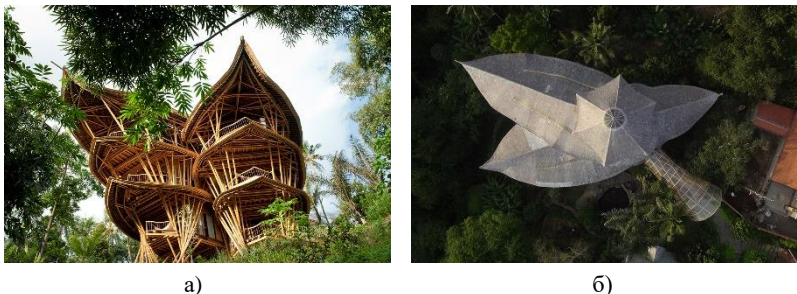
Рис. 3. Жилой дом Sharma Springs, Бали: а) общий вид, б) вид сверху
