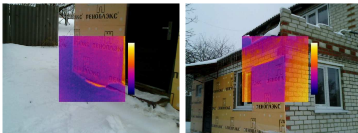
Рис.3. Утепление с помощью пенополистирола Пеноплекс
